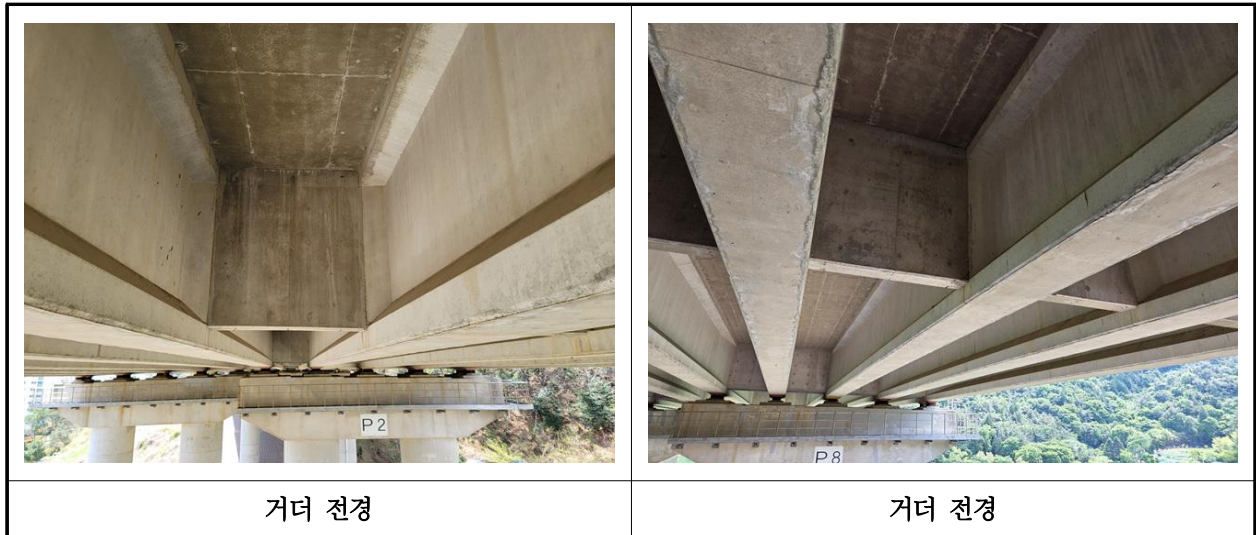
【사진 9.3.4】 거더 전경
