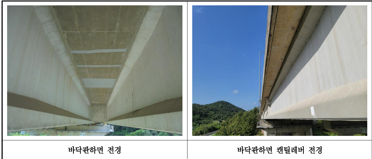
【사진 9.3.2】 바닥판하면 전경
