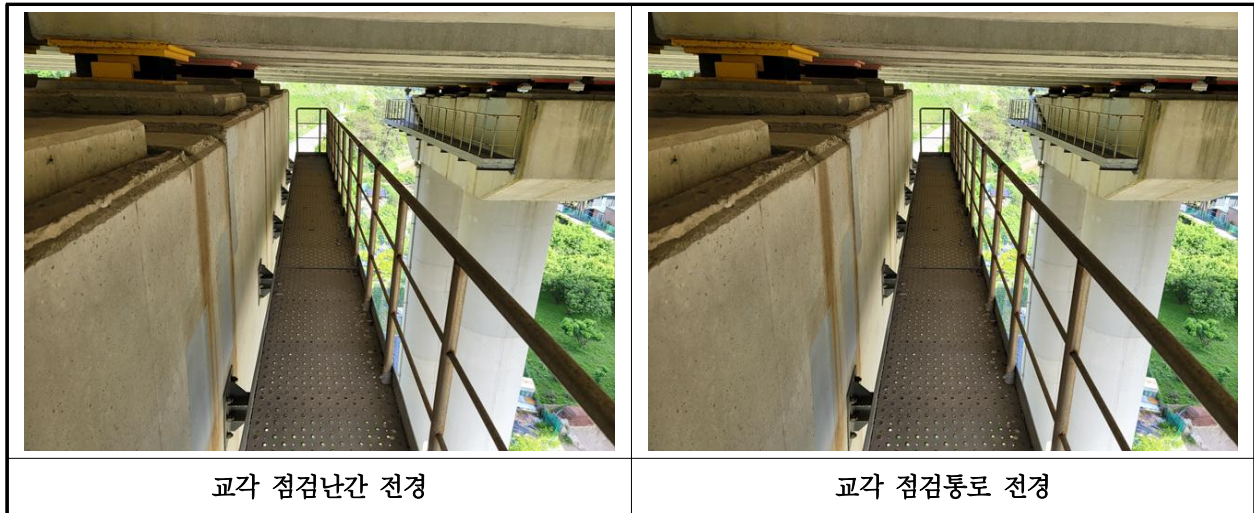
【사진 9.3.26】 교량 점검시설 전경
