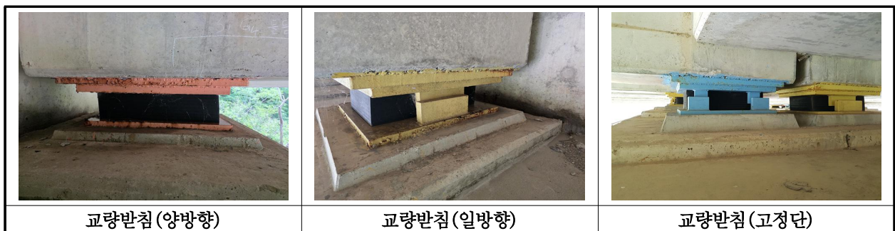
【사진 9.3.13】 교량받침 전경
