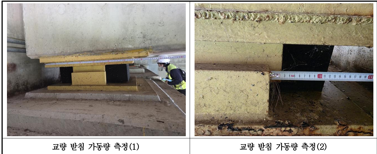
【사진 9.3.16】 교량받침 이동량 측정
