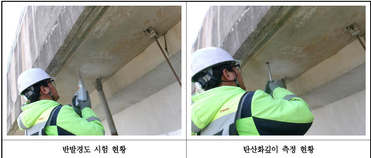
【사진 9.4.1】 콘크리트 내구성조사 현황
