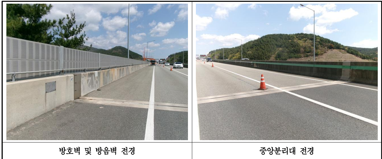
【사진 9.3.24】 방호벽 및 중분대 전경
