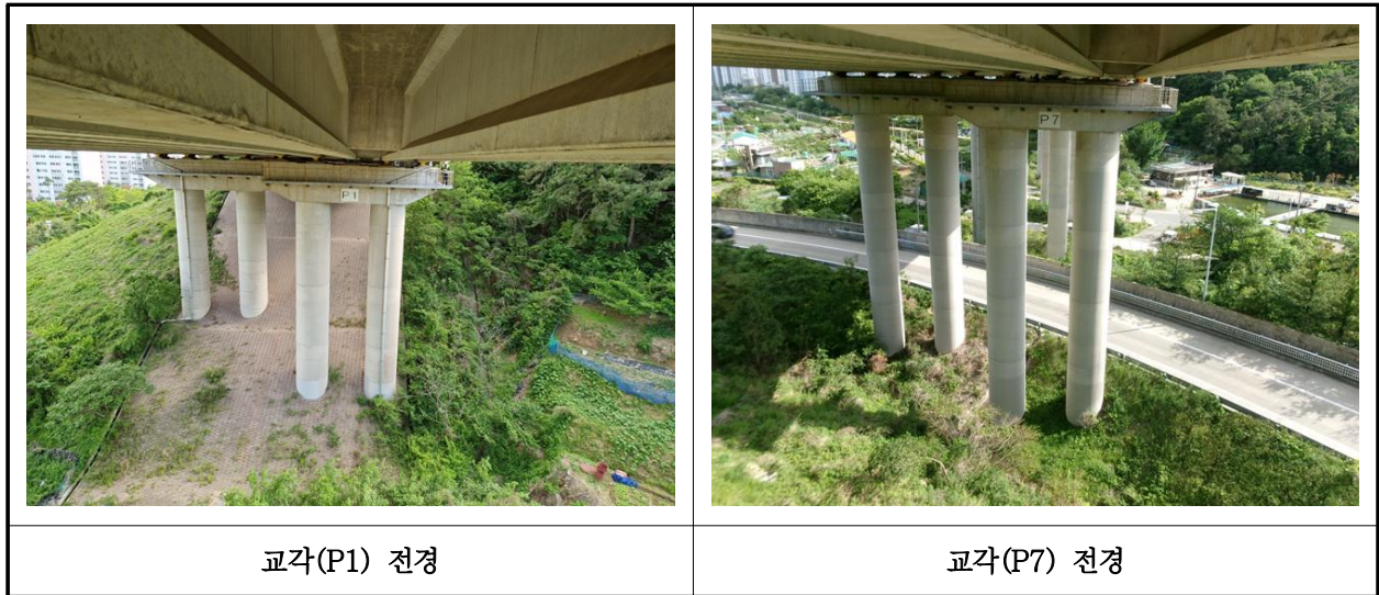
【사진 9.3.10】 교각 전경
