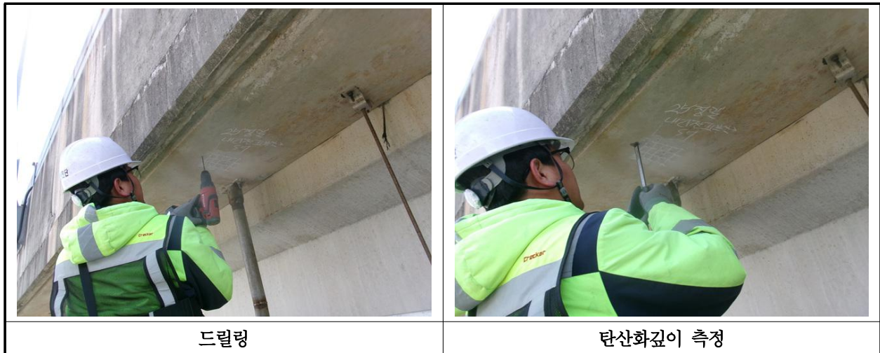
【사진 9.4.3】 탄산화 깊이 측정 현장사진
