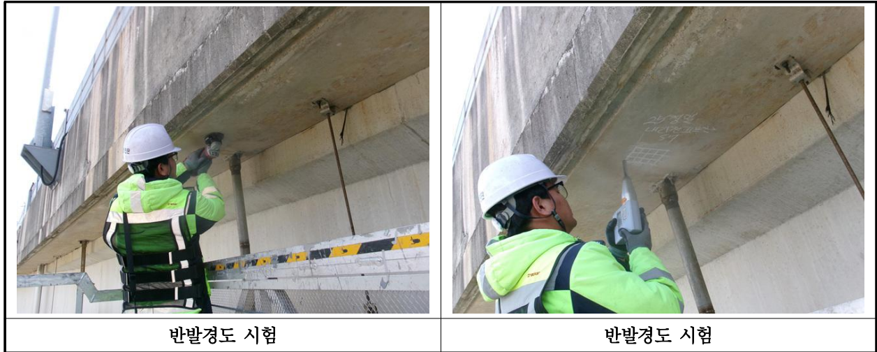
【사진 9.4.2】 반발경도시험 현장사진
