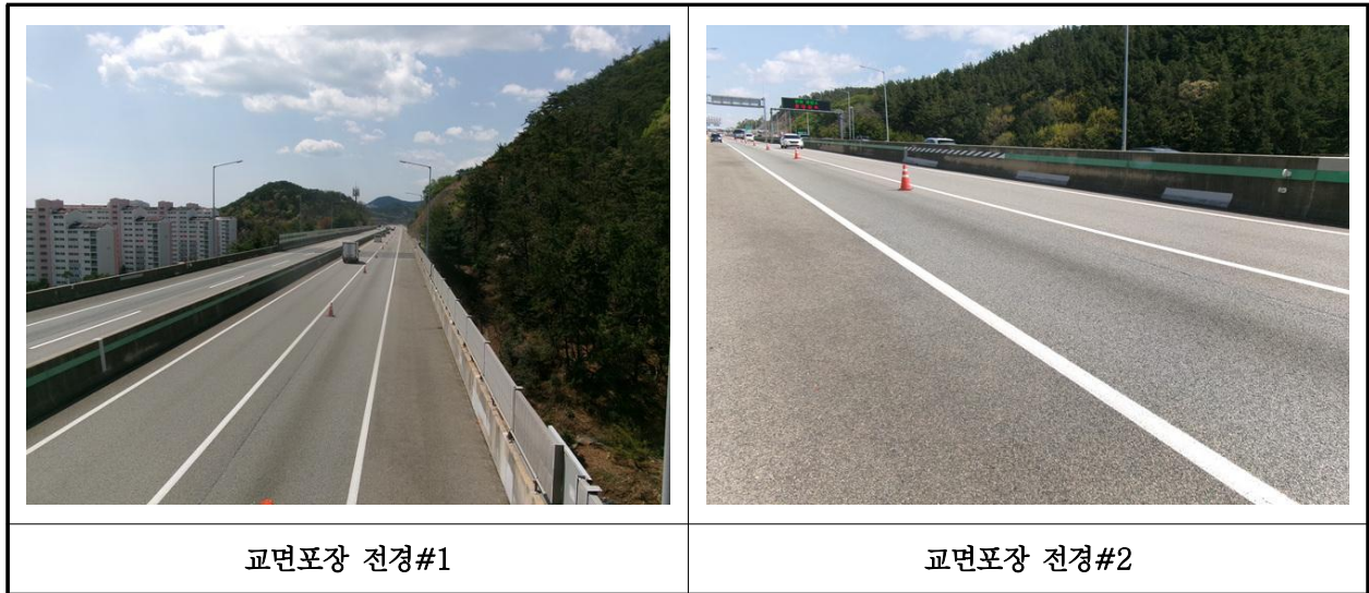
【사진 9.3.20】 교면포장 전경
