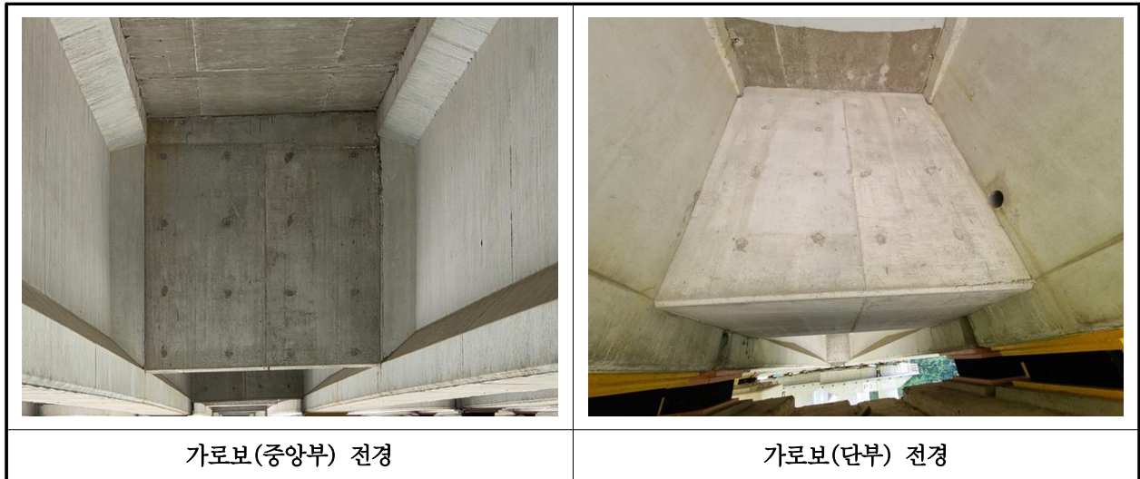
【사진 9.3.6】 가로보 전경
